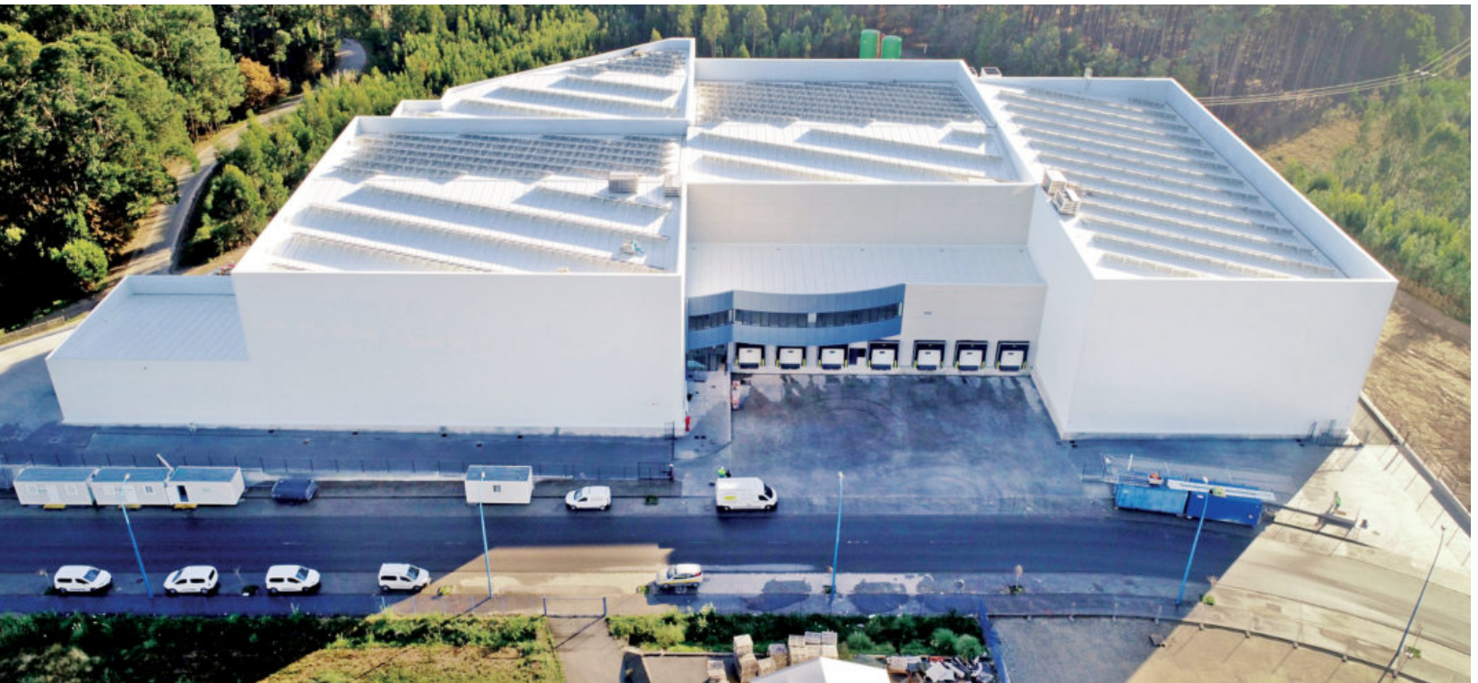
Imagen de las nuevas instalaciones de Frigorifera Coldstore en A Pobra do Caramiñal (A Coruña).
