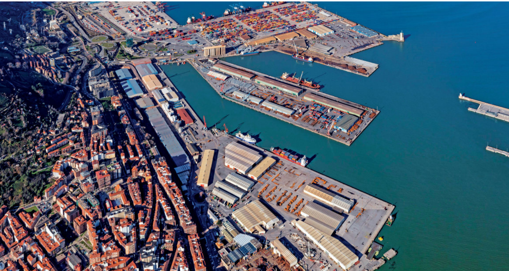
Vista de los muelles Reina Victoria y Bizkaia, en primer plano, donde SLP concentrará sus concesiones destinadas al tráfico de carga general.
