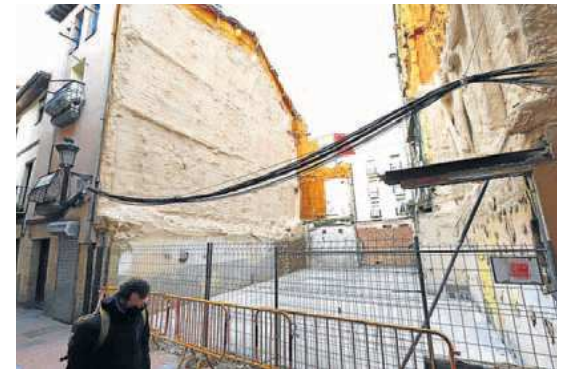
Ya se ha completado el hormigonado de la parcela. A. GÓMEZ
