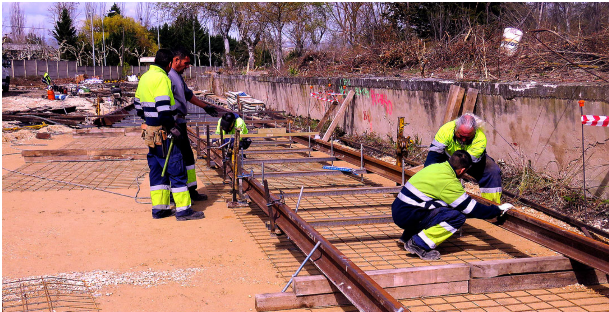
La colocación de las vías se inició hace unas semanas y ya está casi terminada. / FOTOS: R.L.
